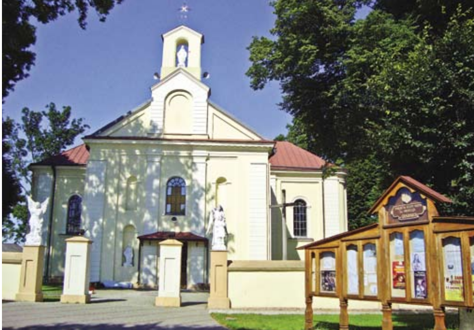
Widok kościoła po remoncie
