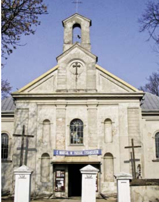
Kościół przed remontem
