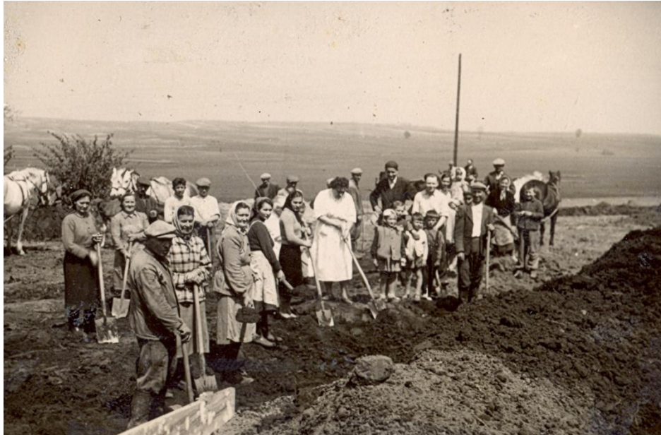
Zdjęcie 18 – Praca ludności przy wykopach na fundamenty budynku ośrodka zdrowia – 1959 rok.
