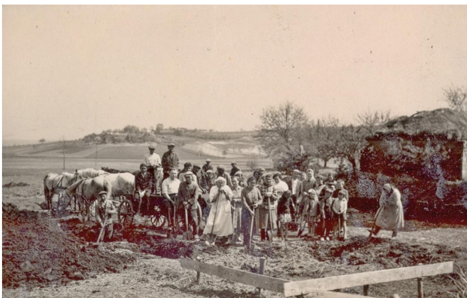
Zdjęcie 17 – Praca ludności przy wykopach na fundamenty budynku ośrodka zdrowia – 1959 rok.
