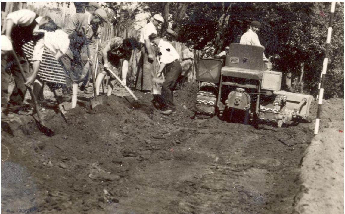
Zdjęcie 20 – Roboty przy dojeździe do budynku ośrodka zdrowia – 1962 rok.
