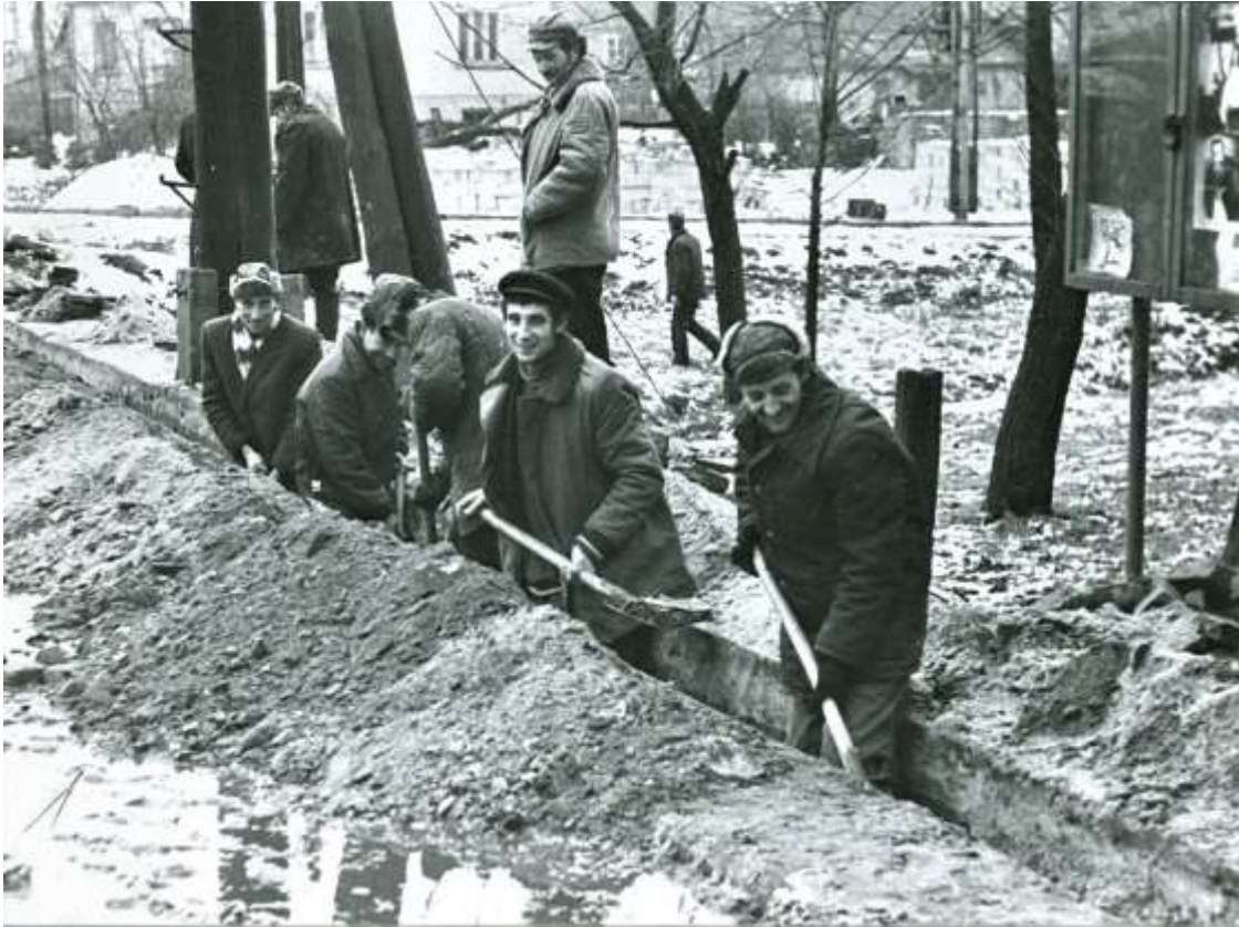
Zdjęcie 1 – Rok 1980. Grabowiec, ulica Wojsławska. Wykopy pod kabel telefoniczny. Zdjęcie ze zbioru Witolda Różańskiego przekazane poprzez Tadeusza Halickiego przez Zbigniewa Różańskiego, syna Witolda.
