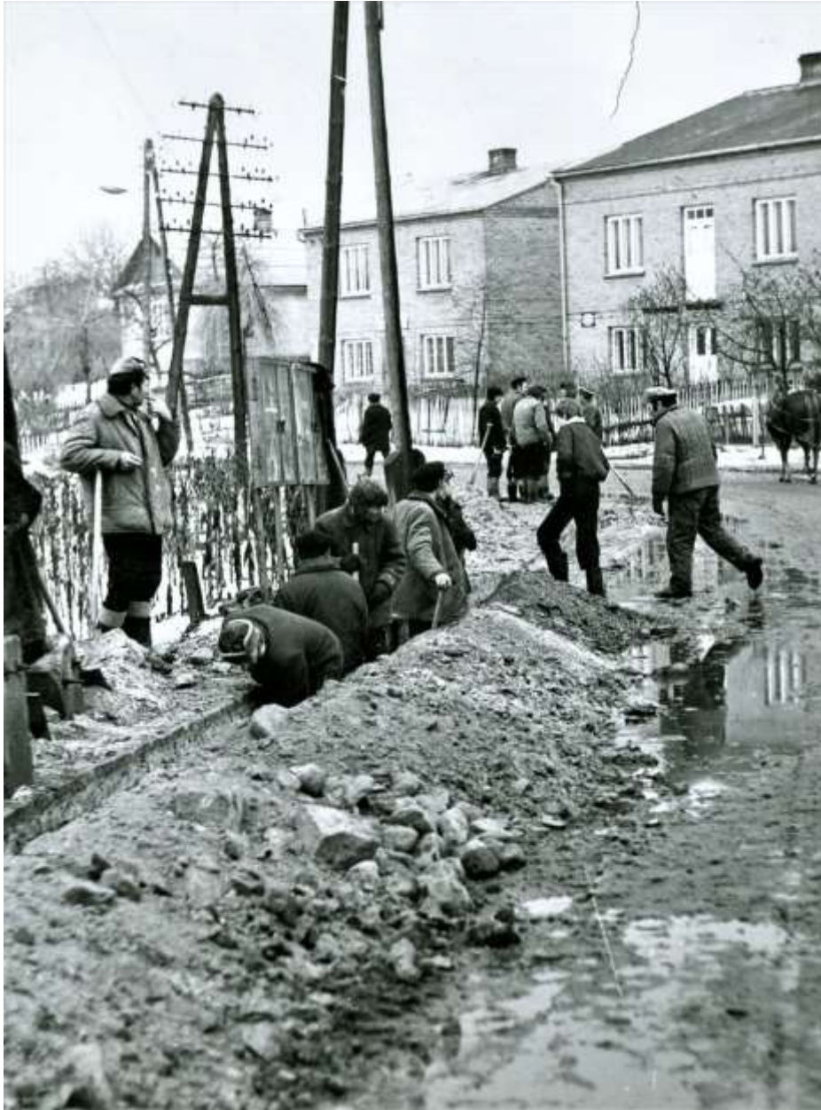
Zdjęcie 2 – Rok 1980. Grabowiec, ulica Wojsławska. Wykopy pod kabel telefoniczny. Zdjęcie ze zbioru Witolda Różańskiego przekazane poprzez Tadeusza Halickiego przez Zbigniewa Różańskiego, syna Witolda.
